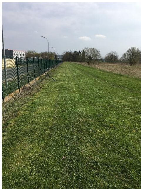
Figure 5-2 : Digue de l'ARC longeant le nord du site
